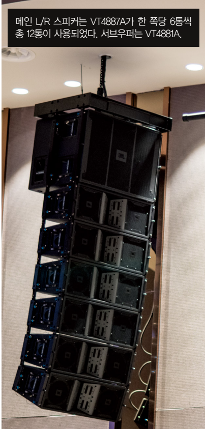
메인스피커는 JBL VT시리즈 라인어레이 시스템이 설치되었다. LED 영상 패널은 Absen의 제품으로 (주)원미디어가 제안 및 시공한 것이다.
